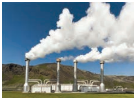
شکل ۱۱-۶- نیروگاه زمین گرمایی مشکین شهر - اردبیل
