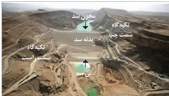
شکل ۵-۴- نمایی از بخش‌های مختلف یک سد
