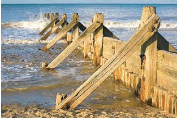
نصب حفاظ عمودی
